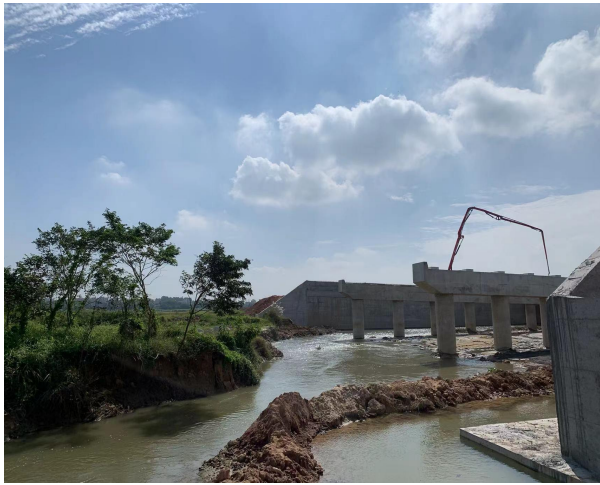
项目遂溪河现状照片
