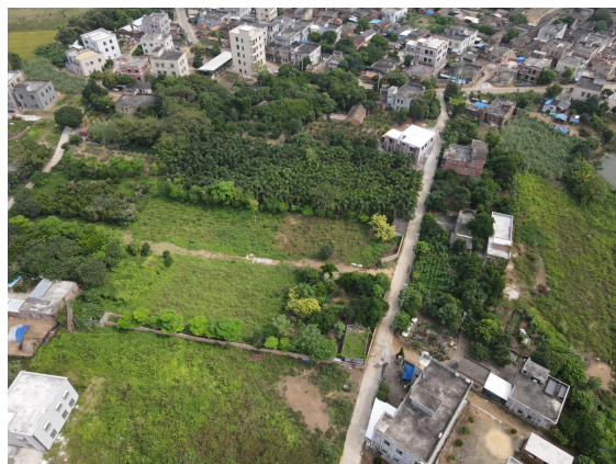
项目主线起点现状
