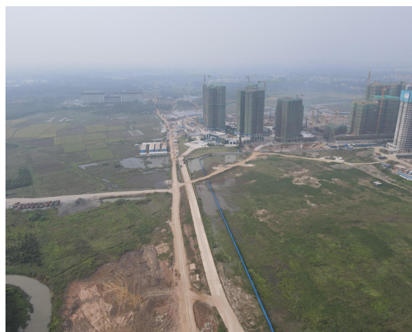
项目中间点现状照片
