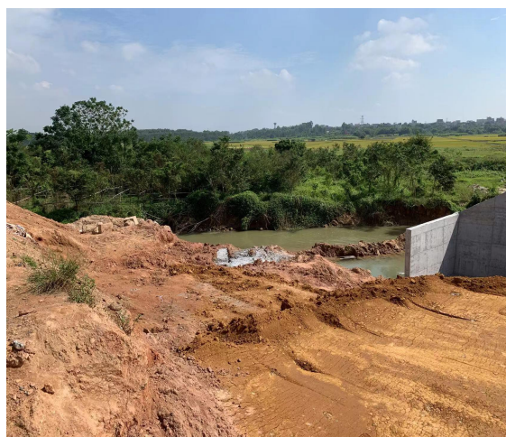
项目中间点现状照片
